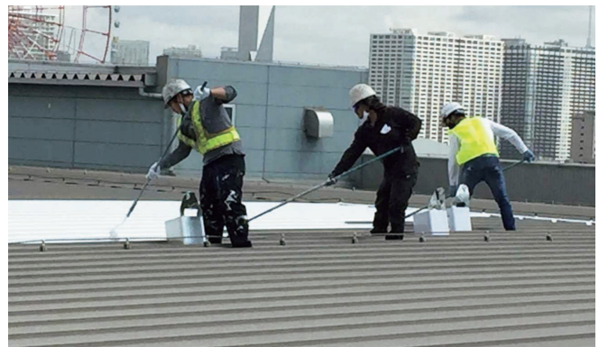
遮熱塗装により工場内の温度を上りにくくする
