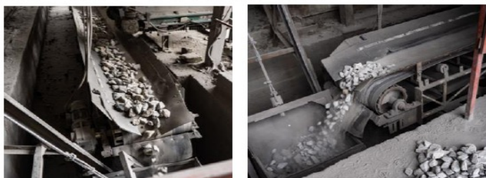
原材料等の搬送端部の飛散防止ガードとして
