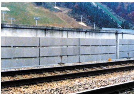
新幹線防音壁
